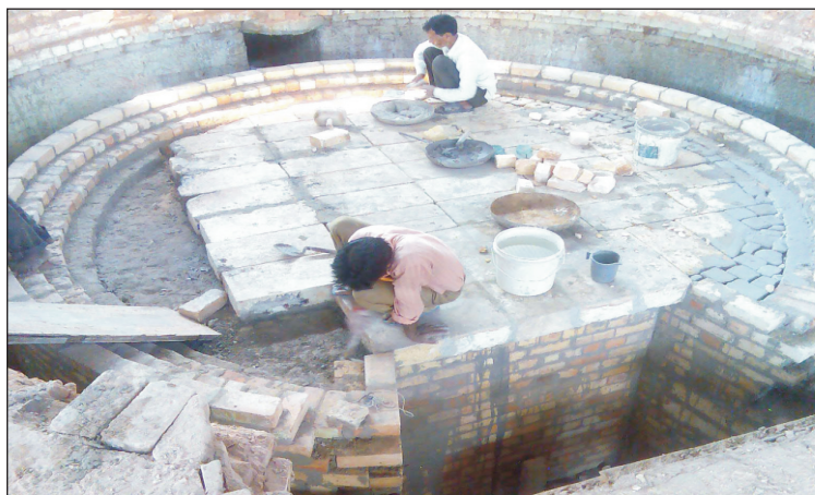
चित्र 35 : रिफ्रेक्टरी मैटेरियल से पॉट भट्टी बनते हुये
